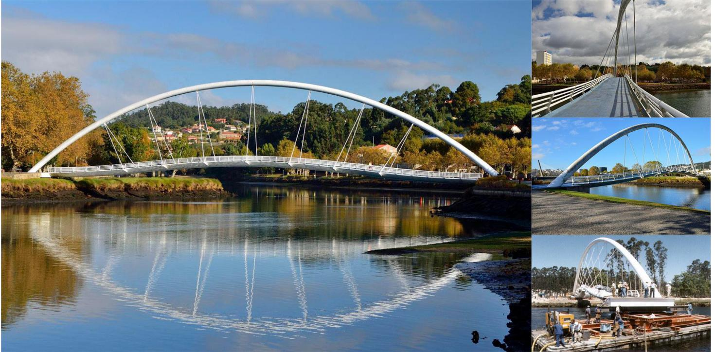
La pasarela peatonal sobre el río Lézrez está compuesta por un arco de tablero inferior de 82,50 m de luz y 13,40 m de flecha. Tanto el tablero como el arco son metálicos. El arco está formado por un tubo de 1,00 m de diámetro. El tablero, de 4,00 m de anchura y 0,80 m de canto, tiene una sección de forma lenticular.
